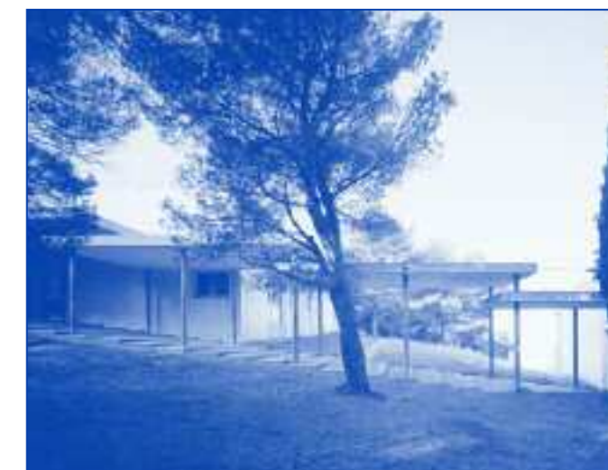
ENSA de Marseille - Galerie couverte entre 2 corps de bâtiment - Photo Jean-Marie Monthiers*
