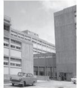
Structure en béton brut, Éléments de remplissage en enduit blanc Hopital du Sacré Coeur, Hazmieh 1961
