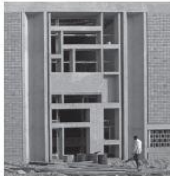
Dispositifs de façade en béton brut Musée National du Koweït, Koweït 1965
